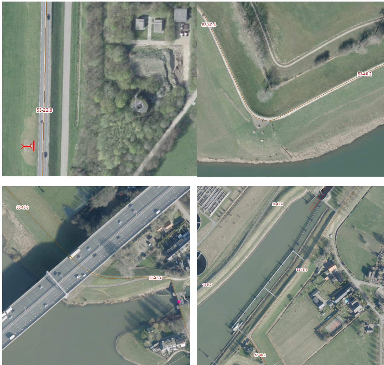
Figuur 6 Overzicht locaties met steenbekleding
