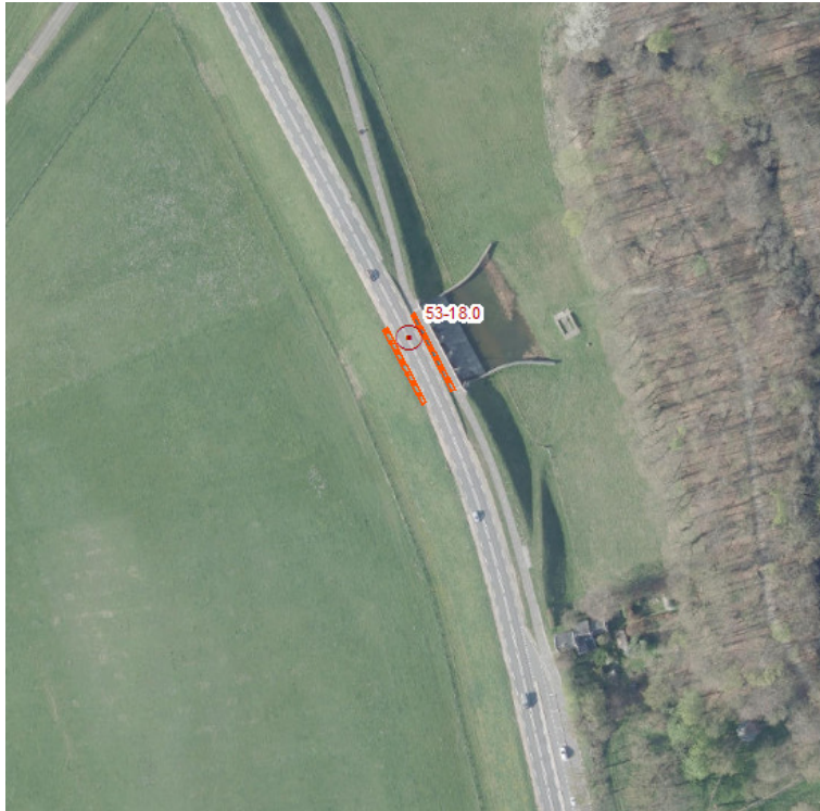
Figuur 8 Bovenaanzicht van het Inlaatwerk
