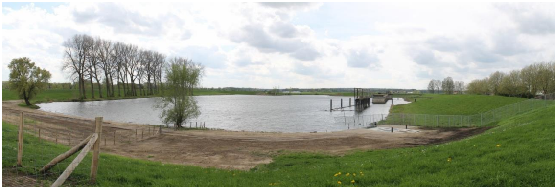
Afbeelding 6.33 Blik vanaf de dijk op de zuidelijke kolk ter hoogte van het gemaal
