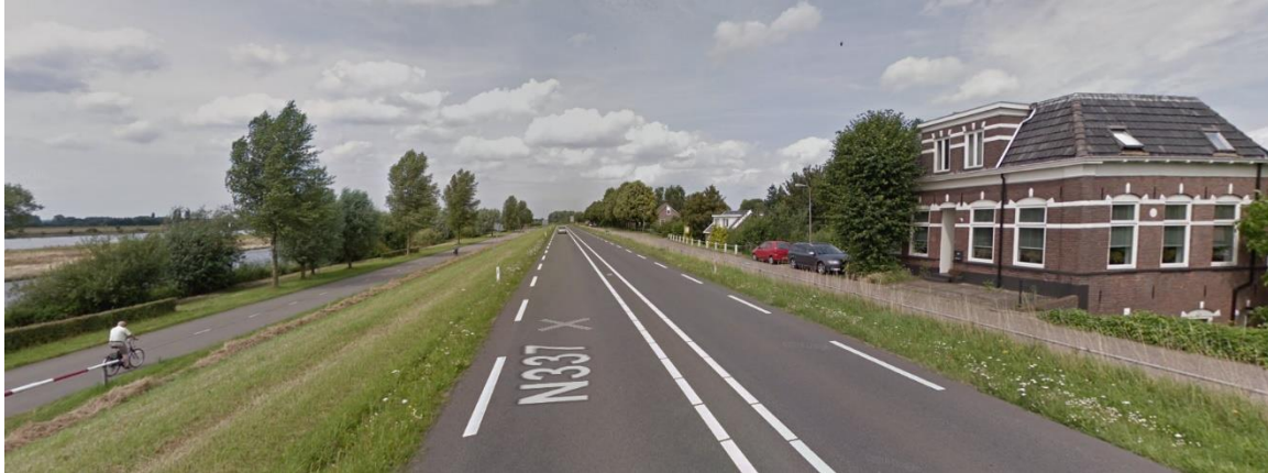
Afbeelding 6.20 Blik op deeltraject 7.2 richting het noorden met links de Veerweg en rechts de parallelweg.
