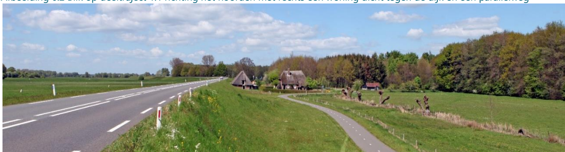
Afbeelding 6.2 Blik op deeltraject 1.1 richting het noorden met rechts een woning dicht tegen de dijk en een parallelweg
