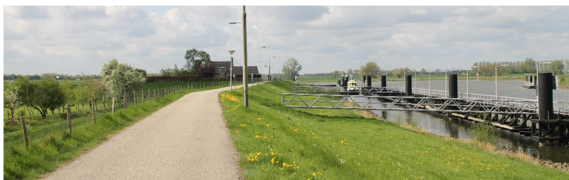
Afbeelding 6.57 Blik op de dijk richting de IJssel met rechts het Zwolle-IJssel kanaal ten westen van de Spooldesluis
