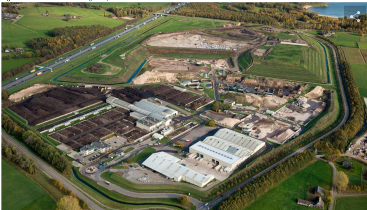
Figuur 2.1: Locatie en inrichting stortplaats De Sluiner
