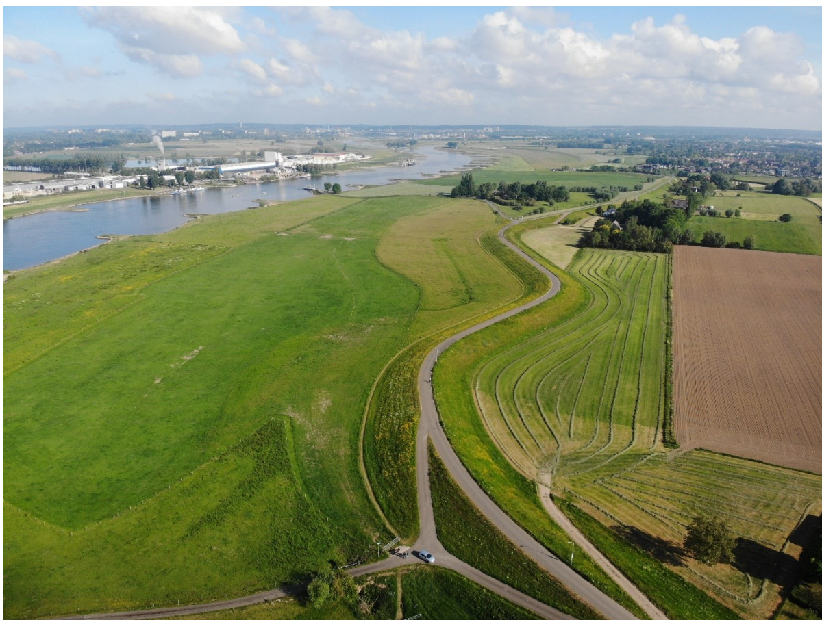
Figuur 2-3 Luchtfoto Looddijk
