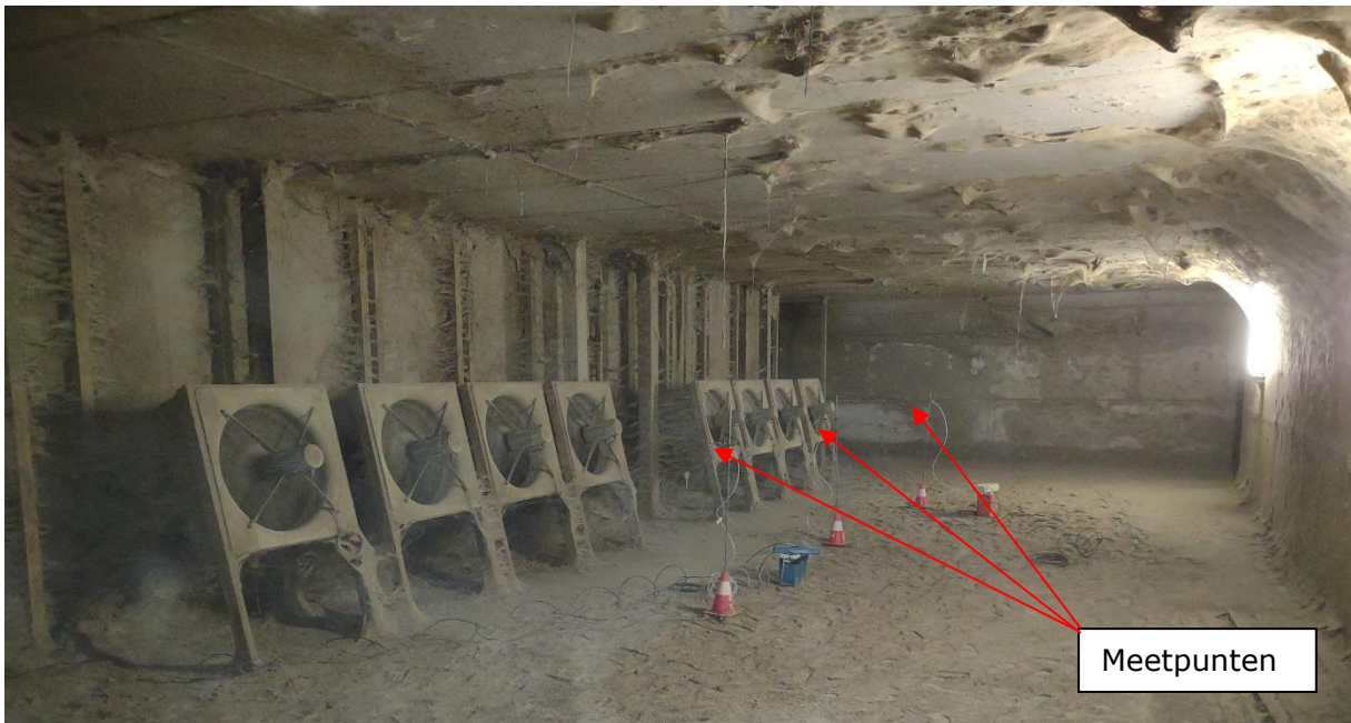
Figuur 2.2 Foto van de meetsituatie van de ongereinigde afgasstroom Wasser Zeugenstal.
