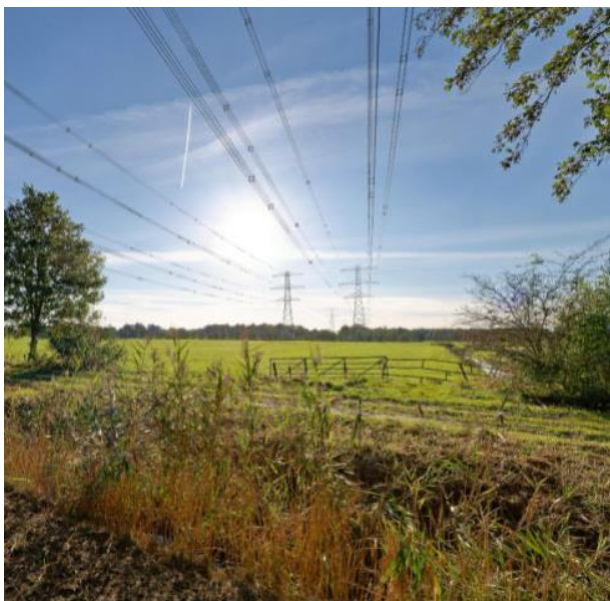
Figuur 2.7 Illustratie van een 380 kV-hoogspanningsverbinding met masttype Moldau op basis van 4 circuits (bron: TenneT)
