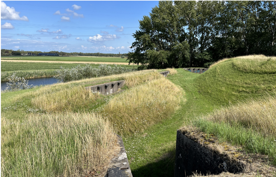
Afbeelding 3.23 Fort aan de Middenweg, zicht op de frontwal met mitrailleurposten
