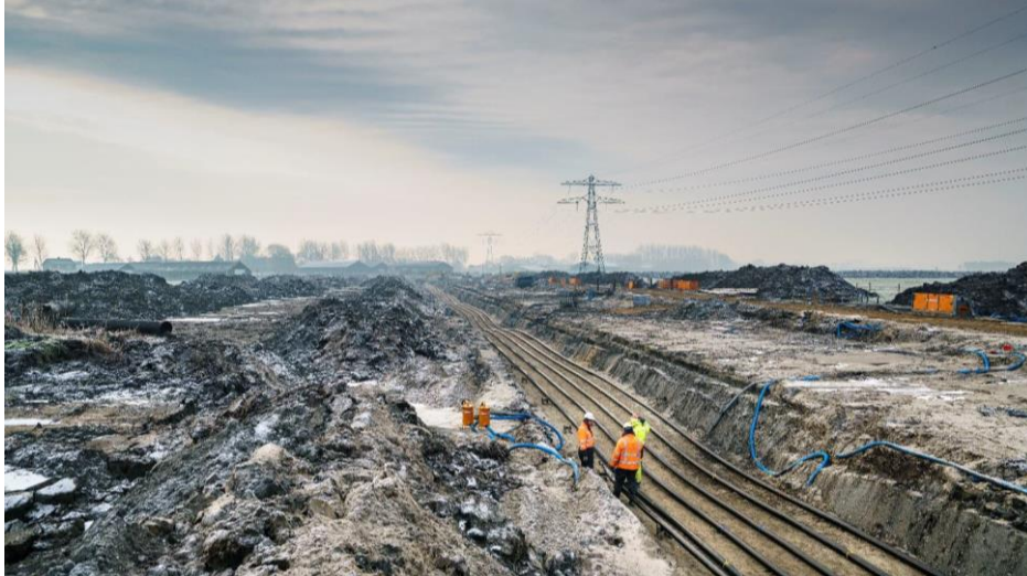
Afbeelding 3.7 Aanleg van een kabelverbinding (twee circuits) in open ontgraving (bron: TenneT)
