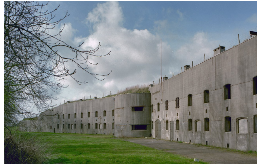
Afbeelding 3.21 Lange gevel van fort Spijkerboor (Bron: Beeldbank RCE)
