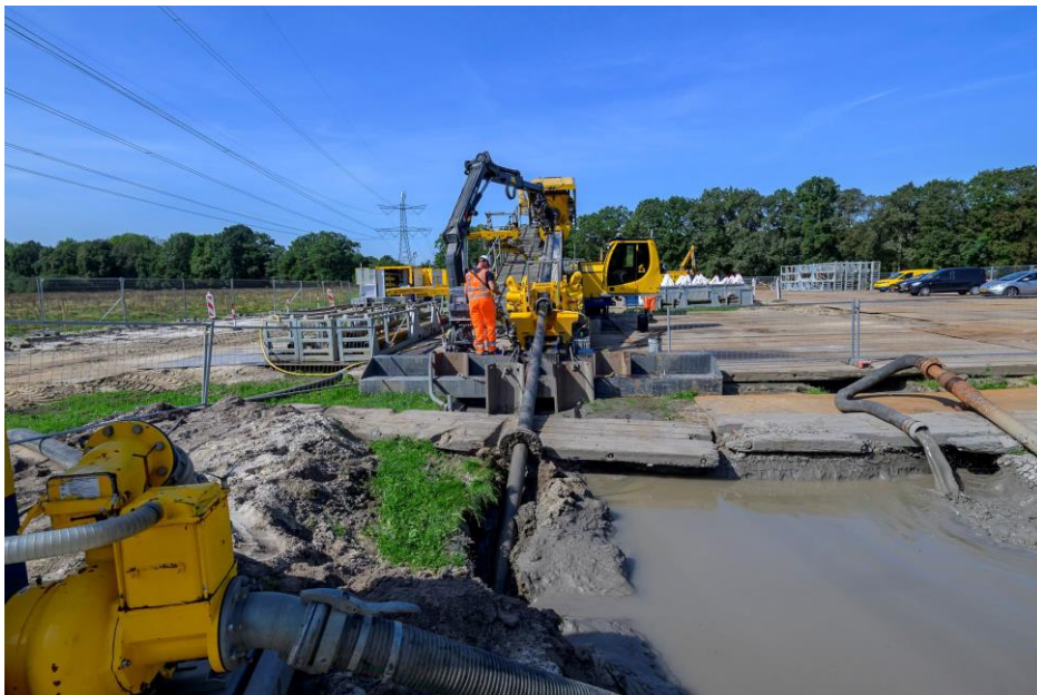
Afbeelding 3.8 Aanleg van een kabelverbinding doormiddel van een gestuurde (HDD) boring (bron: TenneT)
