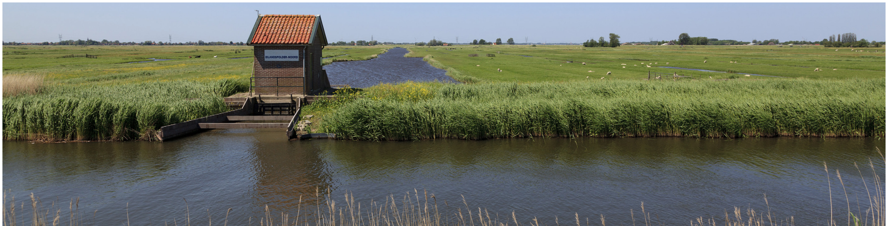
Afbeelding 4.13 Ringvaart grenzend aan de Eilandspolder met het Eilandspolder-Noord Gemaal (Bron: Beeldbank RCE)
