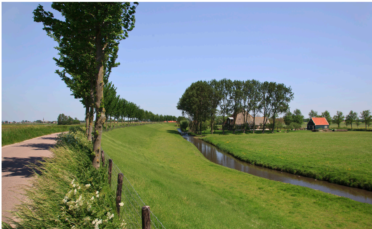
Afbeelding 4.6 Ringdijk, laanbeplanting langs de dijk en stolpboerderij op erf (Bron: Beeldbank RCE)
