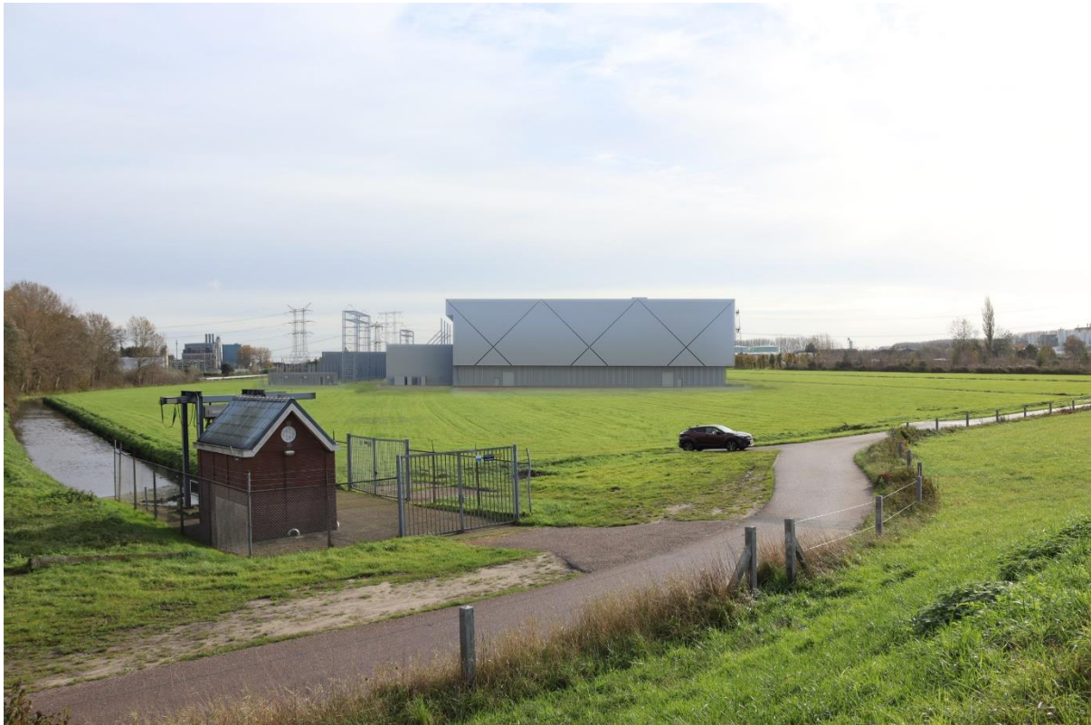
Figuur 6-25 Locatie Heulweg gezien vanaf de dijk langs de Brandweg
