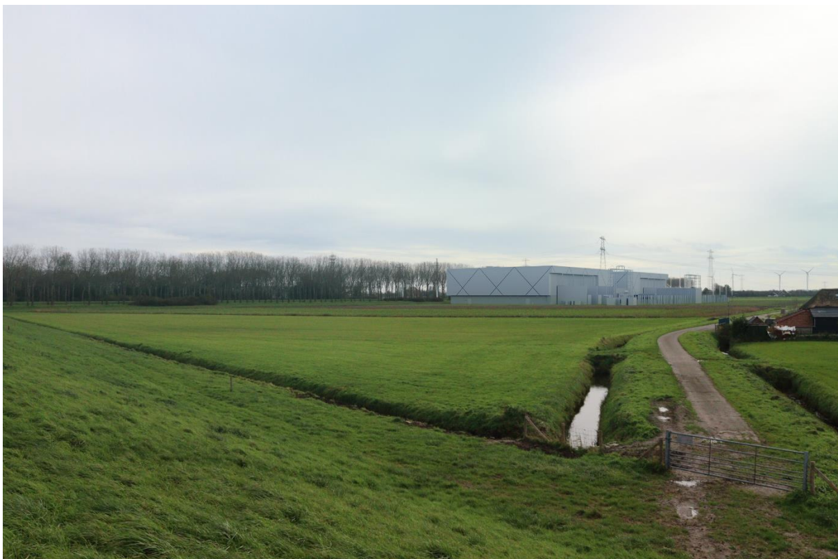
Figuur 6-27 Locatie Amertak West gezien vanaf het fietspad langs de Standhazensedijk
