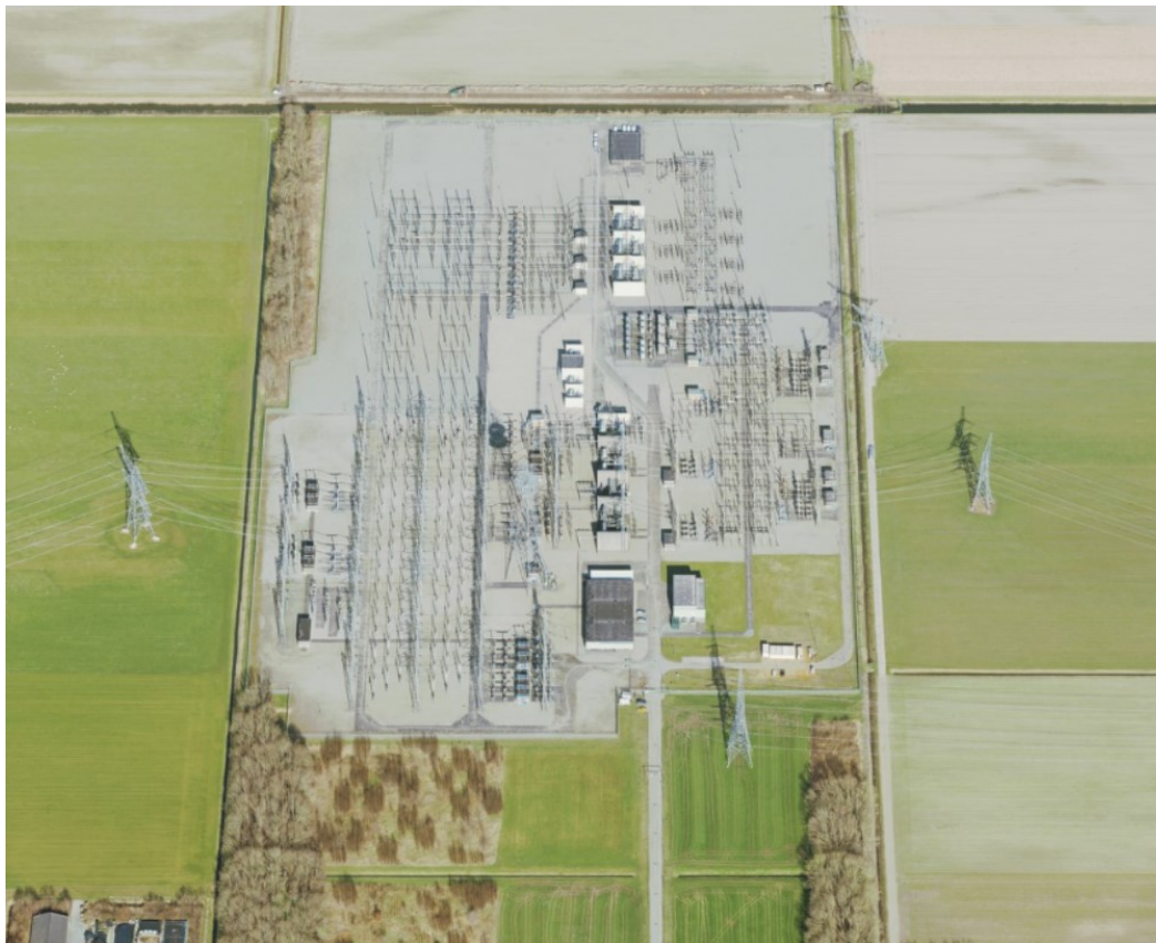
Figuur 1.2 Voorbeeld van een 380 kV-station (Hoogspanningsstation Ens)
