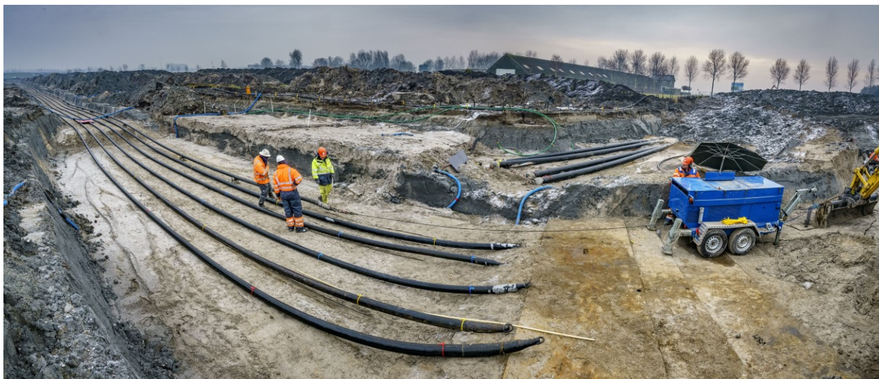
Figuur 5.10 Open ontgraving van 6 kabels (1 circuit)
