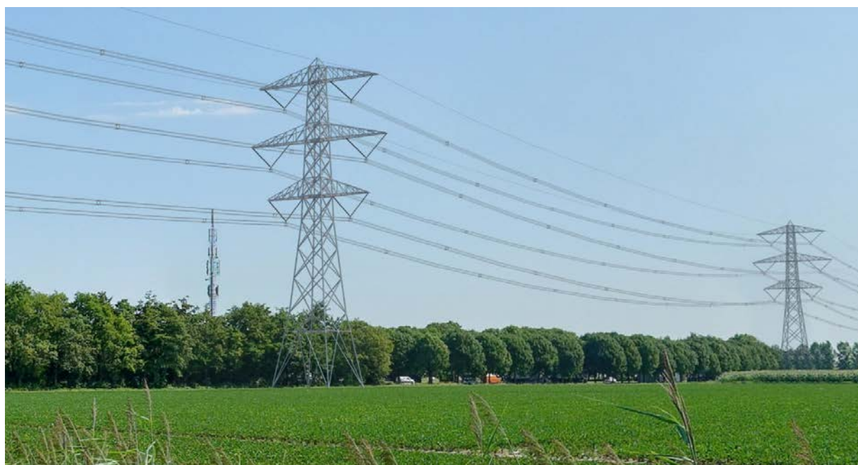
Figuur 5.3 Visualisatie van een Moldau mast in het landschap (bron: projectatlas Zuid-West 380 kV-oost)
