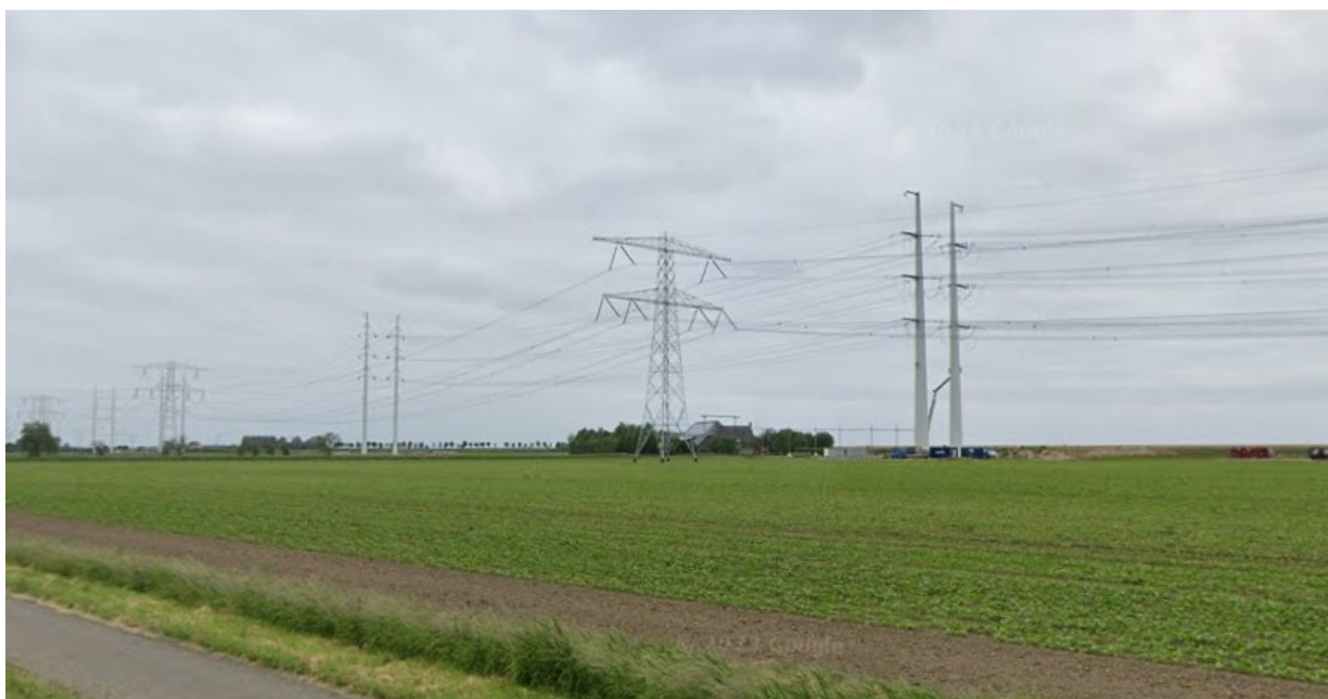
Figuur 5.2 Naast elkaar een 380 kV vakwerkmast ('Eiffeltoren') en een 380 kV wintrackmast (pilaren) (bron: Google Streetview, ter plaatse van A58/N289 nabij Rilland)
