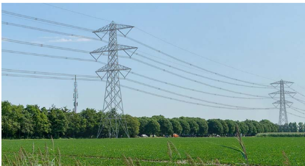
Figuur 1.14 Visualisatie van een Moldau mast in het landschap (bron: projectatlas Zuid-West 380kV-oost)
