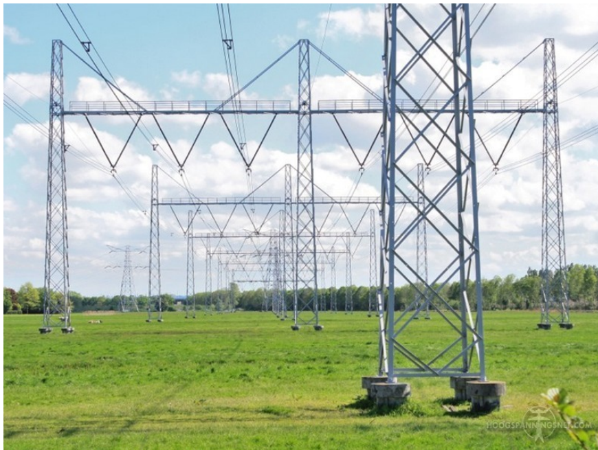
Figuur 8.9 Foto van portalen. Bron: hoogspanningsnet.com
