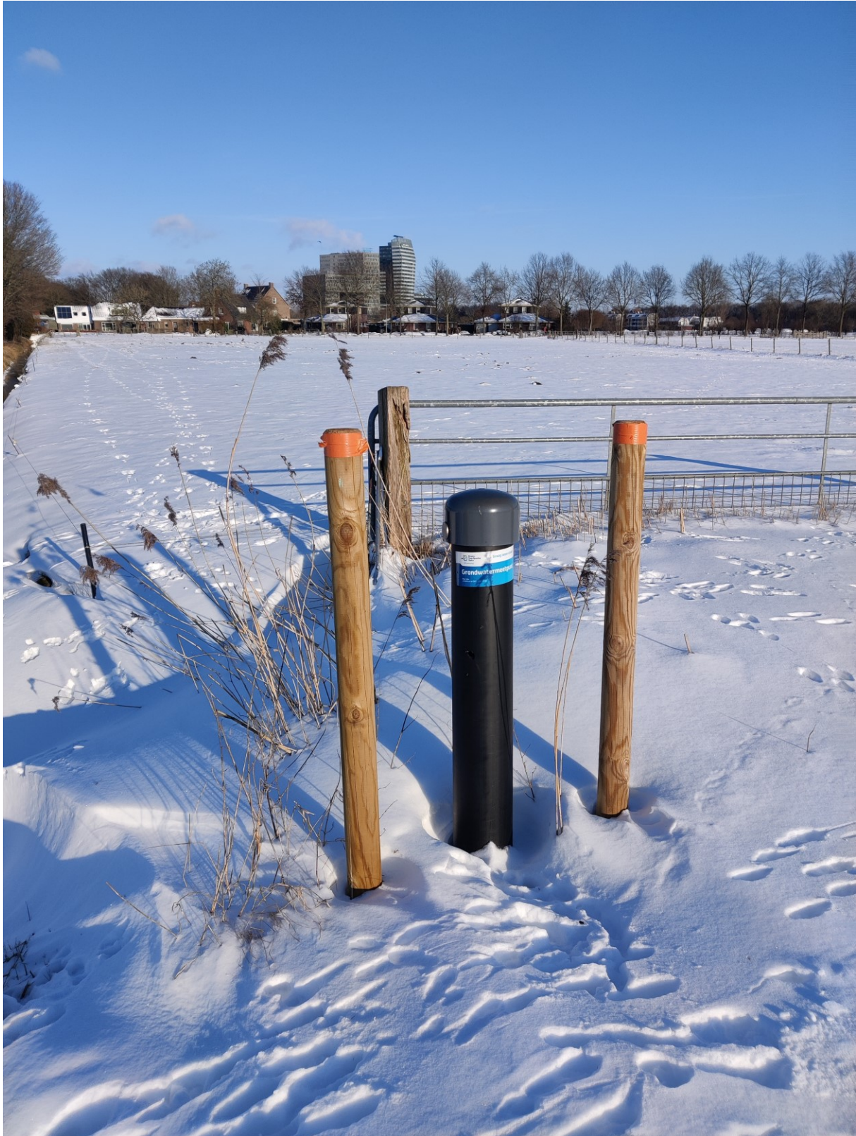
Bijlage afbeelding 28 Situatie ter plaatse van deeltraject 15.3 op 10 februari 2021, kijkrichting naar het oosten, (locatie in RD, X: 200160, Y: 502200). Op dit moment was er sprake van hoogwater op de IJssel (Waterstand nabij Zwolle NAP +2,43 m). Te zien is dat het hoge water niet leidt tot kwel door de sneeuw heen of tot water op het maaiveld. Nabij deze locatie zijn er perceelsslotten, de gemeten waterdiepte is ca. 0,2 m.
