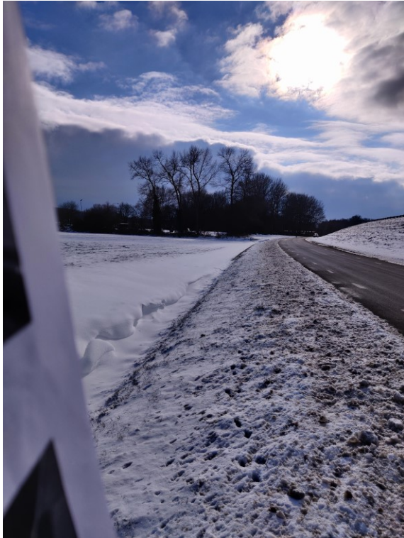
Bijlage afbeelding 12 Situatie ter plaatse van km 30.0 op 10 februari 2021, kijkrichting naar het zuiden, (locatie in RD, X: 206115, Y: 490430). Op dit moment was er sprake van hoogwater op de IJssel (Waterstand nabij Wijhe NAP +4,13 m). Te zien is dat het hoge water niet leidt tot kwel door de sneeuw heen of tot water op het maaiveld. Op deze locatie staat er geen water in de greppel.
