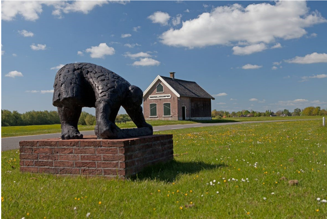
Afbeelding 1.3 Dijkstoel Salland tweede rot een gebouw tussen Wijhe en Olst (nabij Rijksstraatweg 34 Olst)
