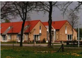
Levensloopbestendige woningen die zo zijn gebouwd dat je elkaar vanzelf ontmoet
