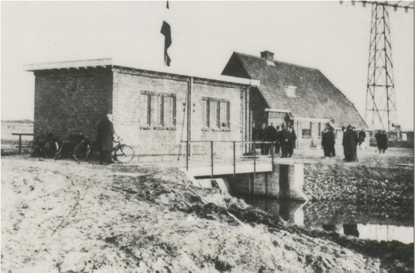
Figuur 31. Opening Gemaal 'Peizer- en Eeldermeden' 1935 – 1936 aan de Hamersweg was belangrijk voor de waterstanden binnen het onderzoeksgebied.
