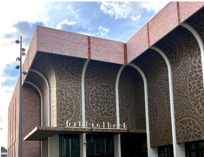
Figuur 58. Patronen aansluitend op cultuur en achtergrond. Rotterdam, Zuidplein Theater
