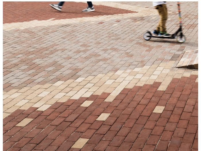
Figuur 83. Aansluiten en aanvullen op gebakken klinkers.
