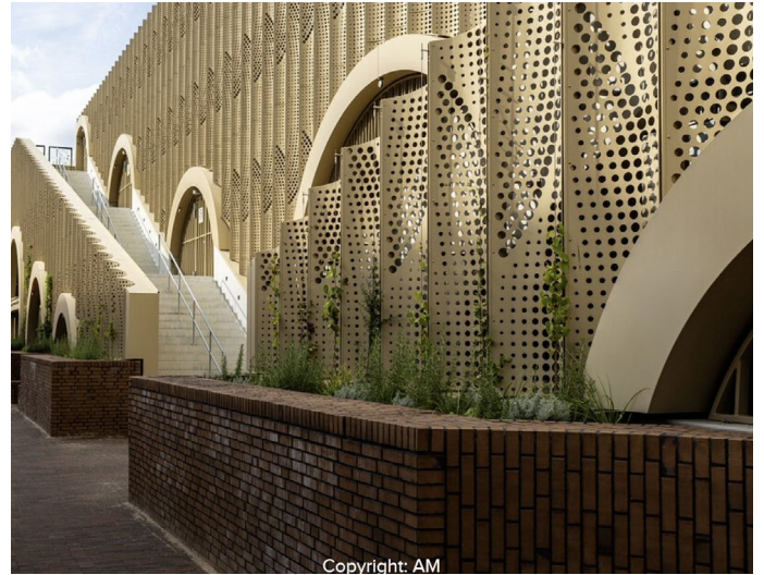
Figuur 46. Zorgvuldig ontworpen gevels met vegetatie. Nijmegen, parkeergarage Waalsprong.
