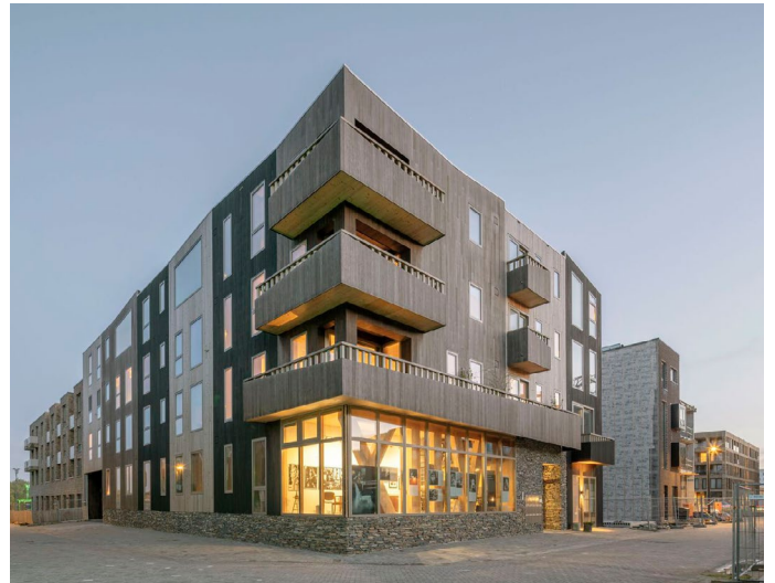
Afbeelding 198. Biobased materialen. Het gebouw is afgewerkt met een houten (deels bamboe) gevelbekleding en een natuurstenen rand. Het gebouw heeft een EPC (Energy Performance Coefficient) van -0,201, is rainproof en natuurinclusief. Het hemelwater wordt gebruikt voor de bewatering van de in het ontwerp verwerkte groene elementen. Amsterdam, Mooijburg, IJburg
