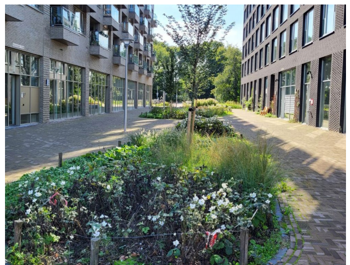
Afbeelding 194. NPD-strook: leidingwerk van WKO ligt ondergronds
