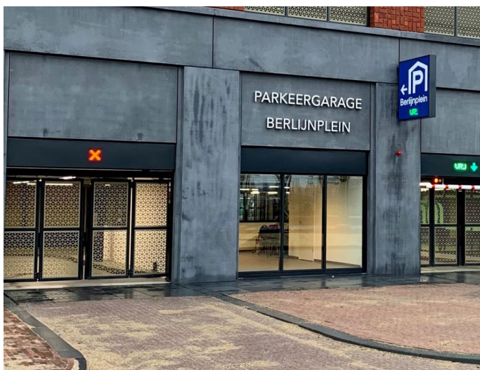
Afbeelding 38. Ingang parkeergarage. Berlijnplein, Utrecht
