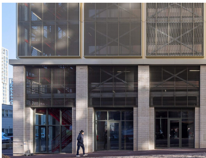
Afbeelding 41. Parkeergebouw onderdeel van het blok. Amsterdam, NDSM
